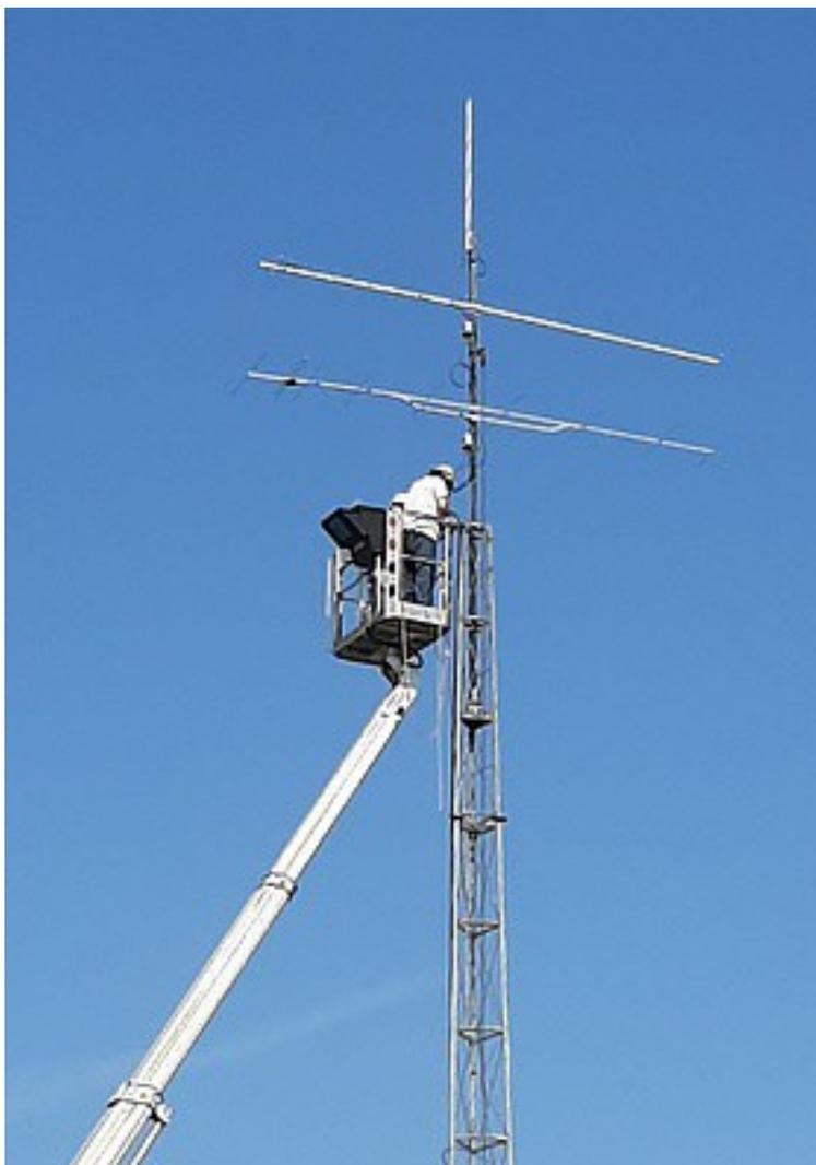
Fixation des différents câbles sur le pylône
